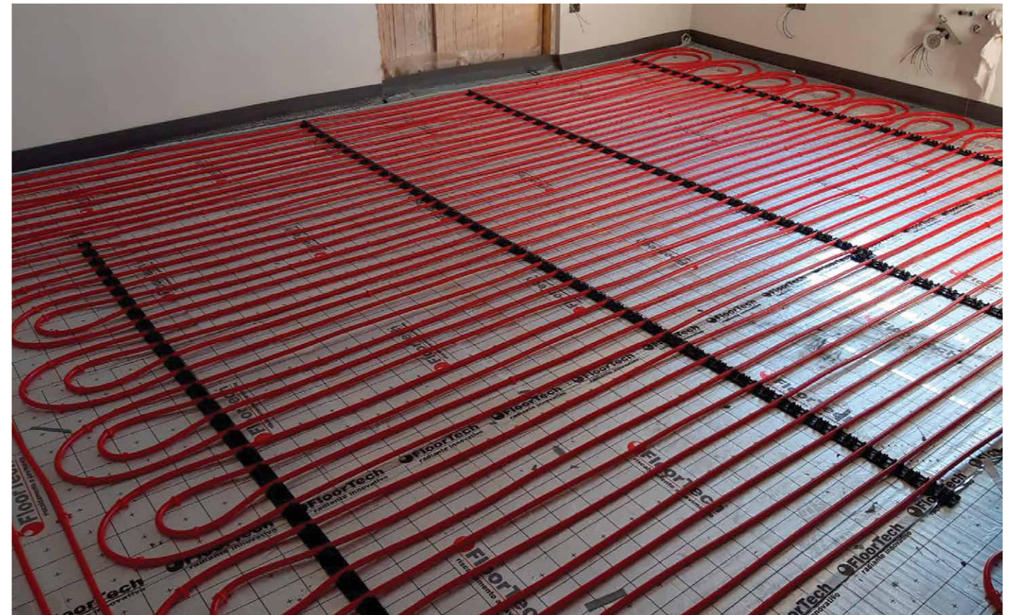
Immagini di posa sistemi ROLL FloorTech. Edificio residenziale.
